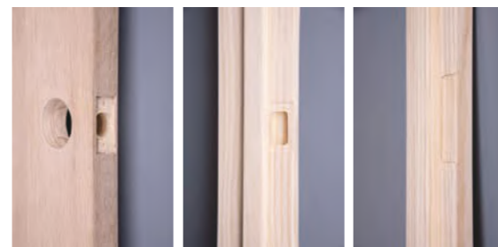
ドアノブ穴/ラッチ受け掘込み/ドア枠ヒンジ掘込み
