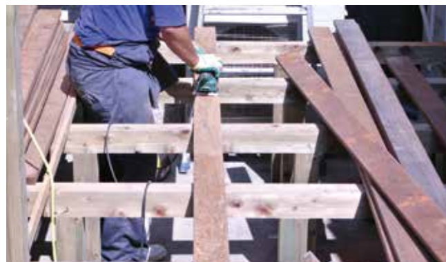
メンテナンス例（表面を研磨）
