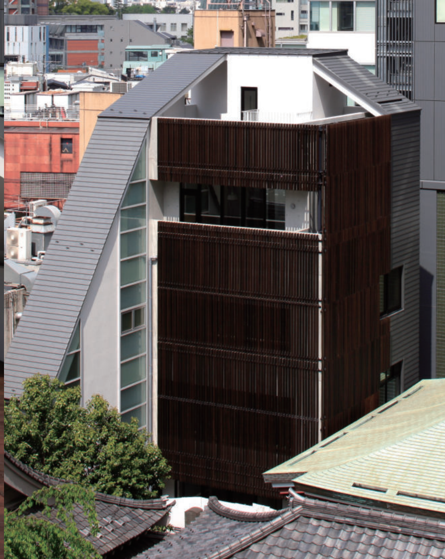
エイバンパー級建築士事務所 *外壁のルーバーとして使用した施工例
