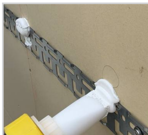
基盤ブリッジに接着剤が絡むため、安全にタイルを保持することが可能
