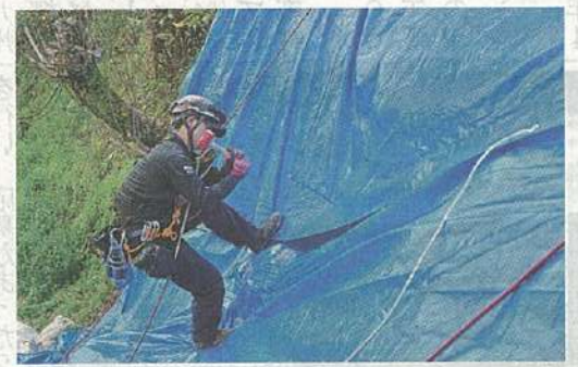
のり面での施工状況
