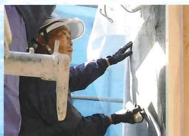
写真4 メッシュ伏せ込み
