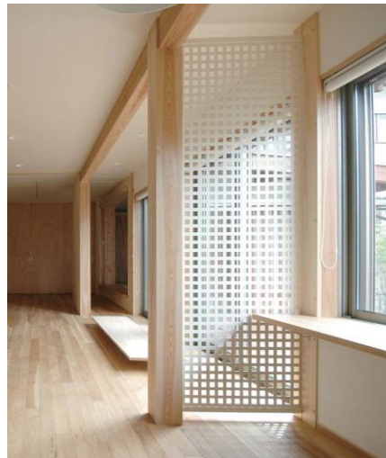
透光型耐力壁「パンチくん」施工例
