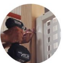
最後にカバー部材を取り付け
