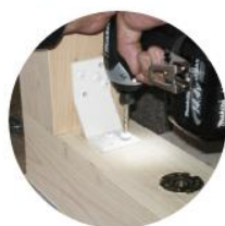
せん断補強金物取り付け
