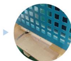
左右・上下のちりを調整しながらパンチングを位置決め ※パンチングは保護シート付
