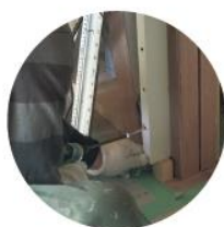
縦枠材角管取り付け
