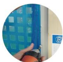
縦横の角管にパンチングを専用ビスで取り付け
