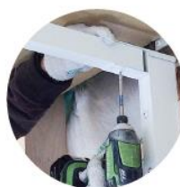
横枠材角管取り付け
