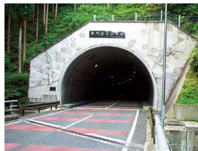
天川村新川合トンネル
