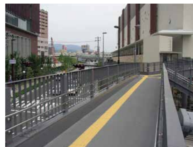
高松町歩道橋(兵庫県)
