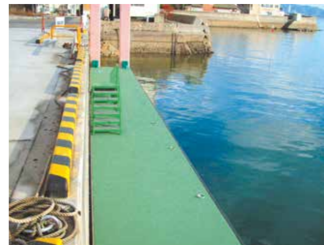
安芸津港浮棧橋(広島県)
