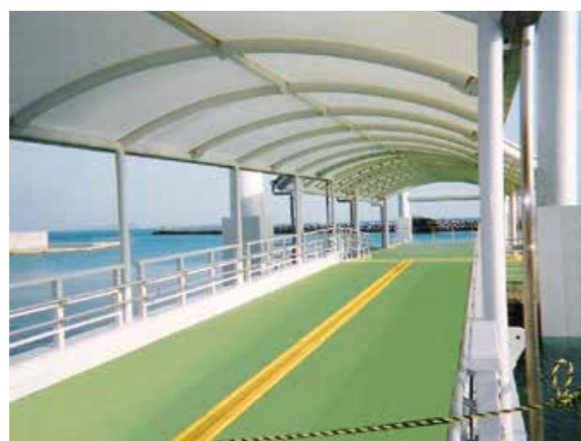
沖縄県黒島浮棧橋・渡橋(沖縄県)
