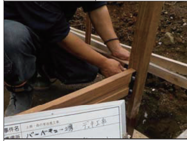
フレームの取付
