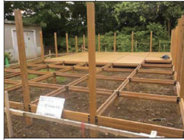
フレーム取付完成
