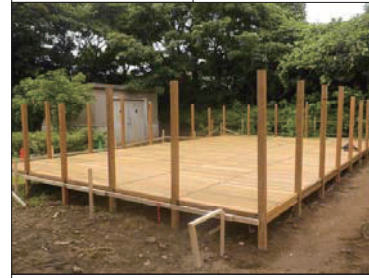
デッキ床面 完成
