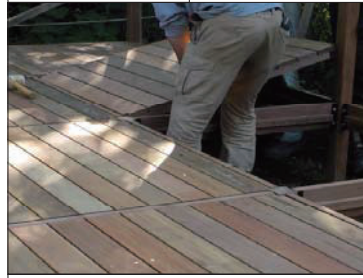
パネルのはめ込み
