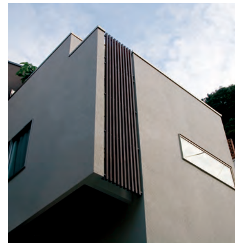
H3000タイプを装飾スクリーンとして使用した施工例
