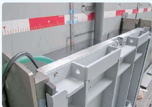
水張り試験中
