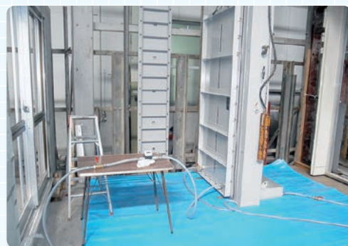
水張り試験中
