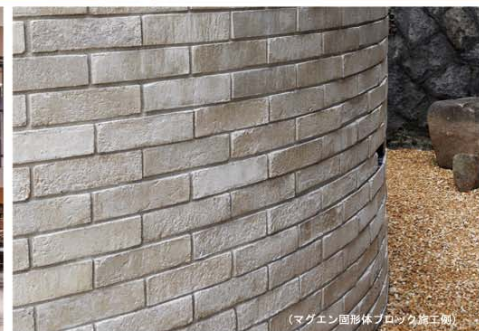
(マグエン固形体ブロック施工例)
