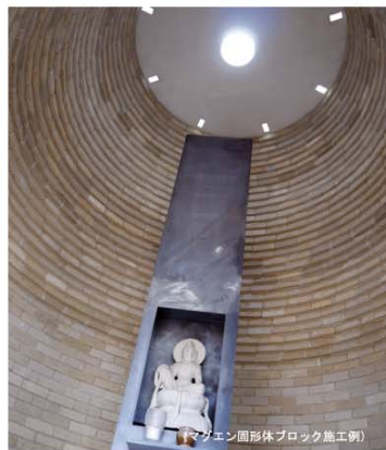
(マグエン固形体ブロック施工例)
