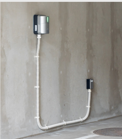
管理組合から駐車場で充電設備の設置を請け負い、テラモーターズ製EV充電器と、クラウド一括管理のためのIoT機器を設置します。
