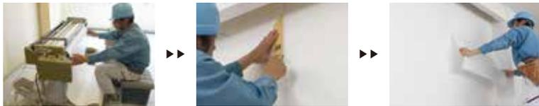
壁紙と同様に糊付けします。化学反応率は60%を維持。
