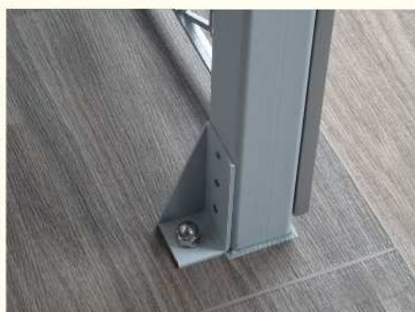
柱は特注のベースで固定されています。
