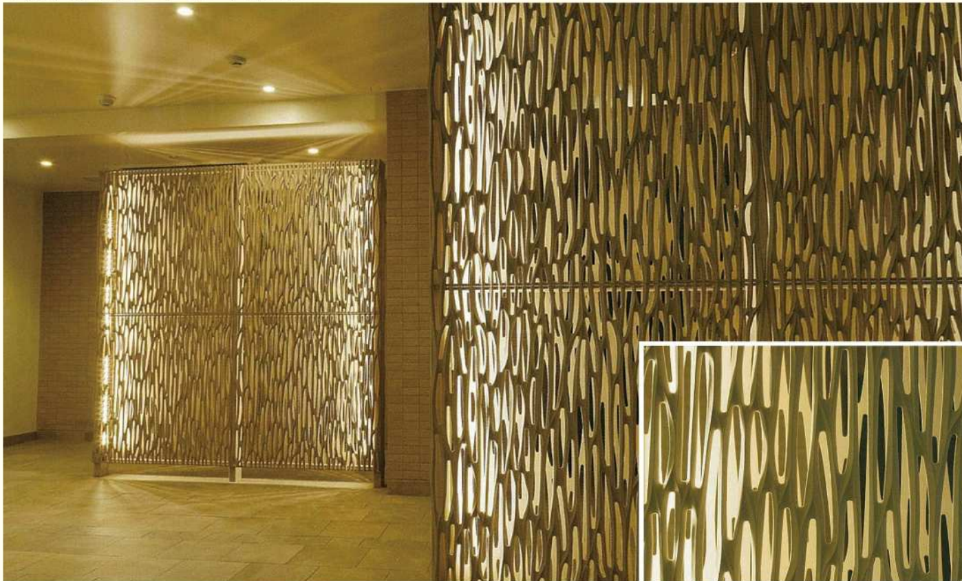
『せせらぎ』パネルを前後にとりつけて、内部に照明が組み込まれています。
