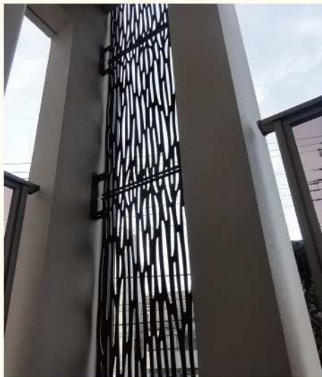
『せせらぎ』パネルを前後にとりつけて、内部に照明が組み込まれています。
