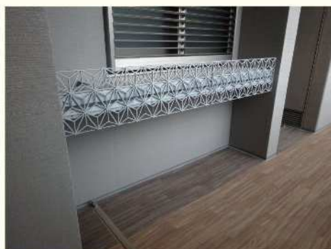
室外機置場の上はプランター置場になっています。
